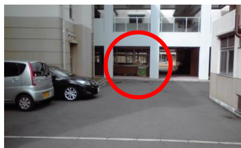
北九州市立ひびきが丘小学校
